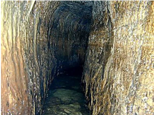
De door koning Hizkia aangelegde tunnel.
